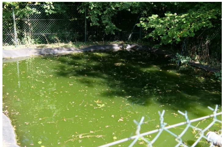
Décantation eaux de lavage filtre
