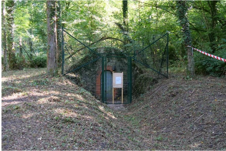
Local d'accès à la chambre de captage
