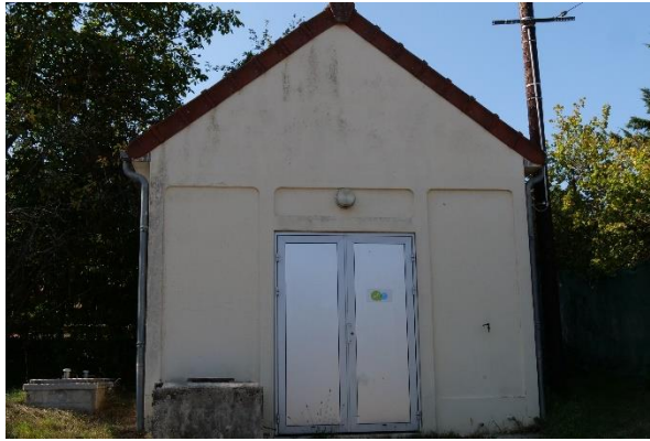
Local des installations de déferrisation
